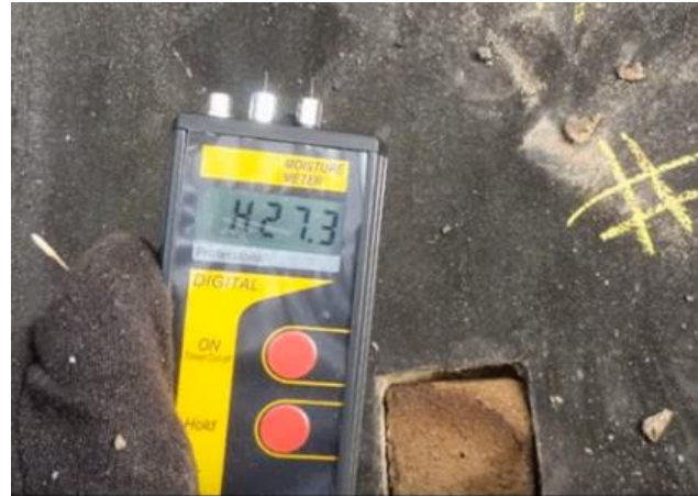
(d) Use of a penetrating moisture probe to evaluate the extent of moisture damage
